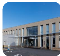
南部生涯学習センター
